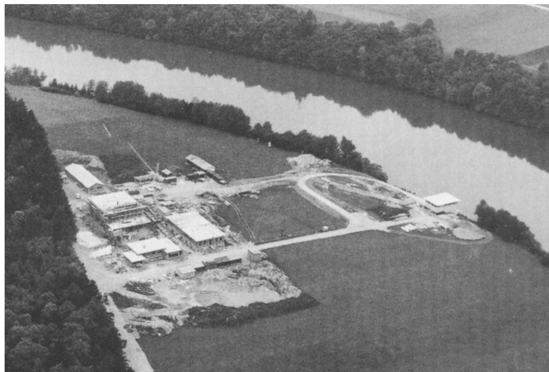
Würenlingen 1955. Ganz links das Saphir-Gebäude im Bau
